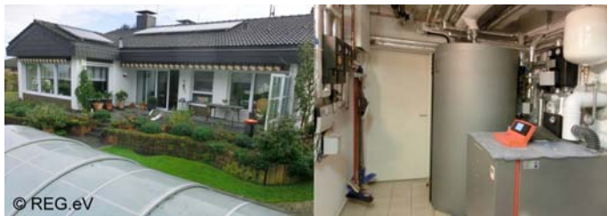
Wohnhaus mit Sonnenkollektoren auf dem Dach und abgedecktes Schwimmbad davor sowie Heizungsraum, u.a. mit Schichtenspeicher und Steuerung auf der linken Wand
